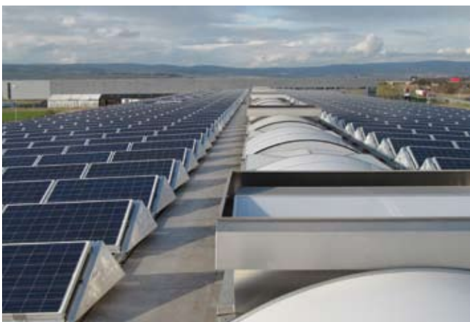
Referenzanlage Logistikzentrum Bingen am Rhein
